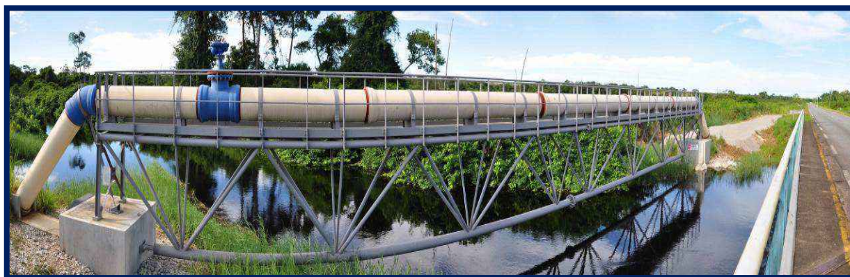
Figure 28 : Les aménagements liés à l'AEP peuvent influencer de manière permanente sur la dimension paysagère comme la conduite d'adduction d'eau de l'usine de Matiti (crique Macouria) (S.Clavier / HYDRECO)
