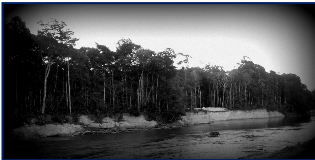
Figure 30 : Erosion des berges en aval de la centrale hydroélectrique de Saut Maman Valentin sur la Mana (S. Clavier / HYDRECO)
