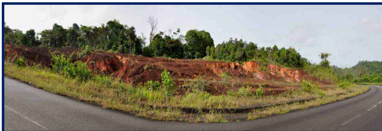
Figure 38 : Décompacter la latérite après les travaux d'aménagement permet la repousse des plantes pionnières locales et limite les phénomènes d'érosion (S. Clavier / HYDRECO)
