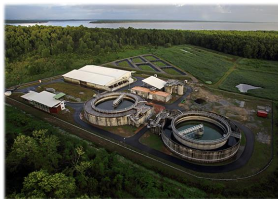
Station d'épuration, boues activées - crédit : CACL
