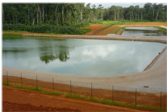
Station d'épuration, lagune – crédit : CACL
