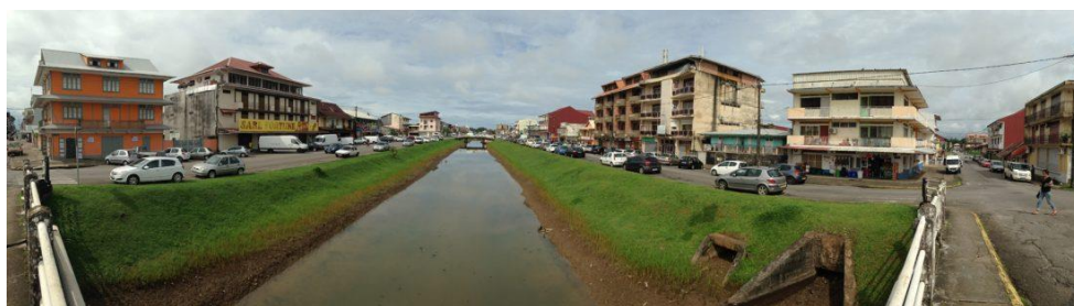
Aménagement des berges du canal de Laussat, Cayenne, crédit : services municipaux de la ville de Cayenne
